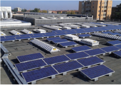
Protezione dei lucernai sui tetti con impianto fotovoltaico
