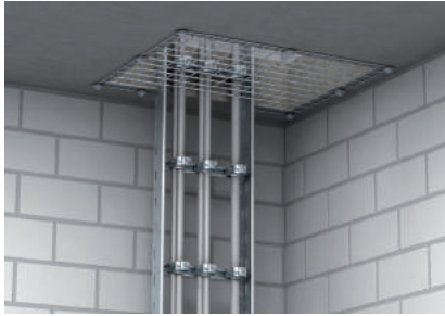
Installazione griglia in acciaio contro la caduta dei sacchetti nei passaggi verticali
