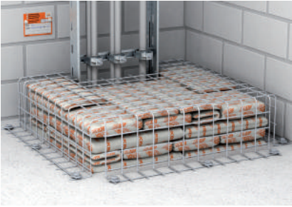
Installazione griglia in acciaio contro lo scivolamento dei sacchetti al di sopra dei passaggi verticali
