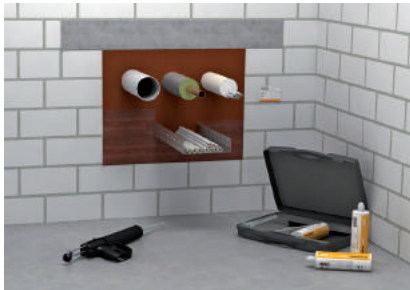
Chiusura dei piccoli spazi con schiuma PYROSIT® NG
