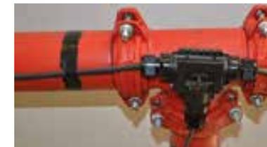
Connessione di cavi scaldanti (Italia).
