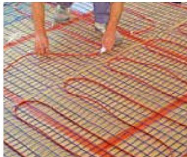
Giunzione di cavi scaldanti.
