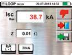
Advanced Loop: esito negativo verifica potere d'interruzione.
