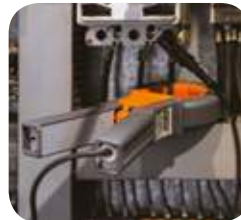
Misura di corrente di dispersione con pinza opzionale HT96U.
