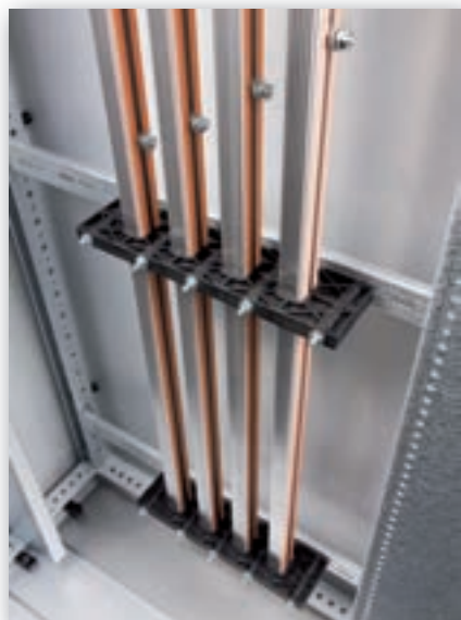
Montaggio vano cavi
