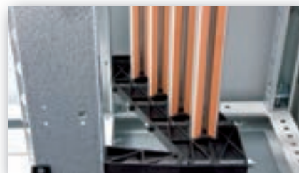
Montaggio vano cavi L=400mm
